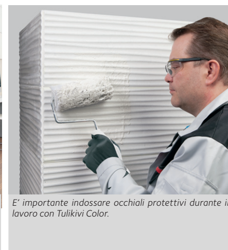
11. Quando l'ultima mano sarà asciugata, ricollocare gli sportelli al loro posto. Ecco che la stufa Tulikivi è come nuova! Si consiglia di lasciare asciugare la superficie per una settimana prima di avviare il primo ciclo di riscaldamento.
