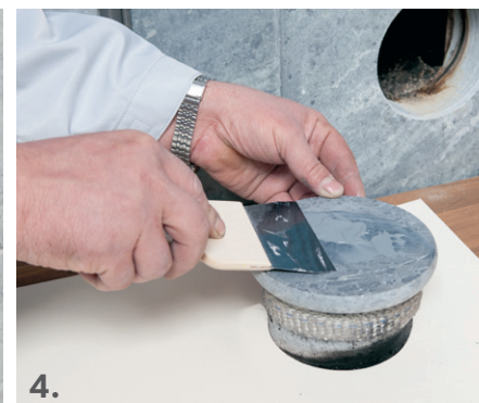
4. Ragréer les petites traces d'impact et les fissures avec un mastic plastique de type Pakla.
