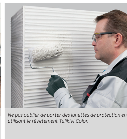
11. Lorsque le revêtement est sec, réinstaller les portes en place. Votre poêle-cheminée Tulikivi est maintenant comme neuf ! Noter que la surface doit sécher une semaine avant la réutilisation.
