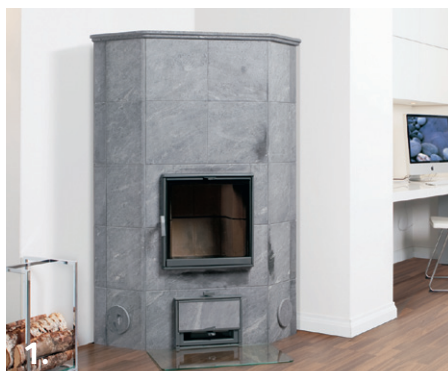
1. Commencer le travail de revêtement par un nettoyage en profondeur. Nettoyer la surface du poêle avec une eau savonneuse (produit vaisselle).
