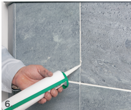
6. Pressen Sie den Tulikivi Color-Fugenmörtel mit einer Silikonpresse in die Fugen, jedoch immer nur eine geringe Menge auf einmal.
